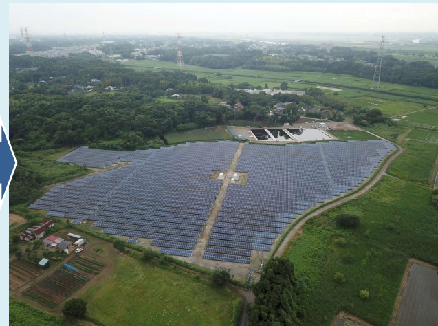
増設後の発電所
