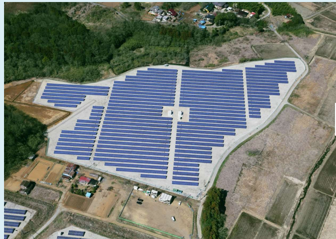
増設前の発電所
